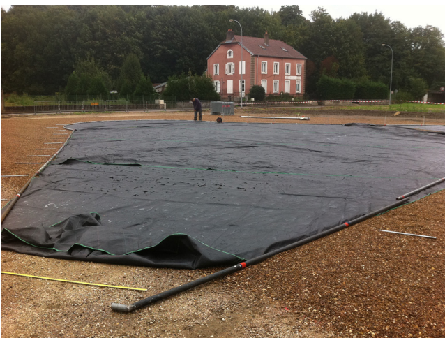
Installation du "patron" qui correspond à la surface de la Bulle au sol
